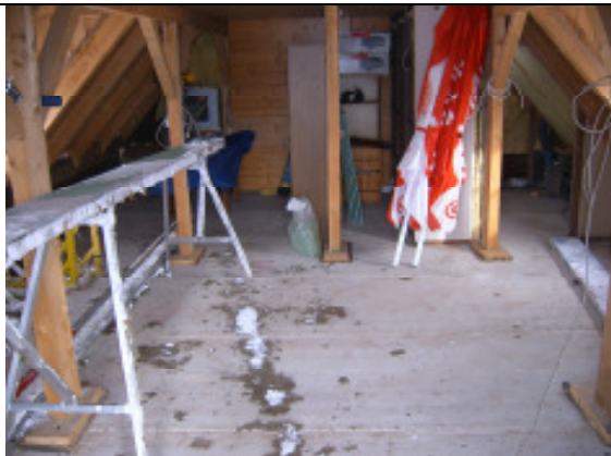
Dachboden zusammengeräumt NEU
